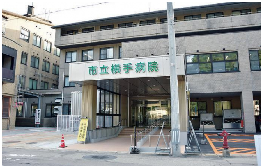
完成した公園口
